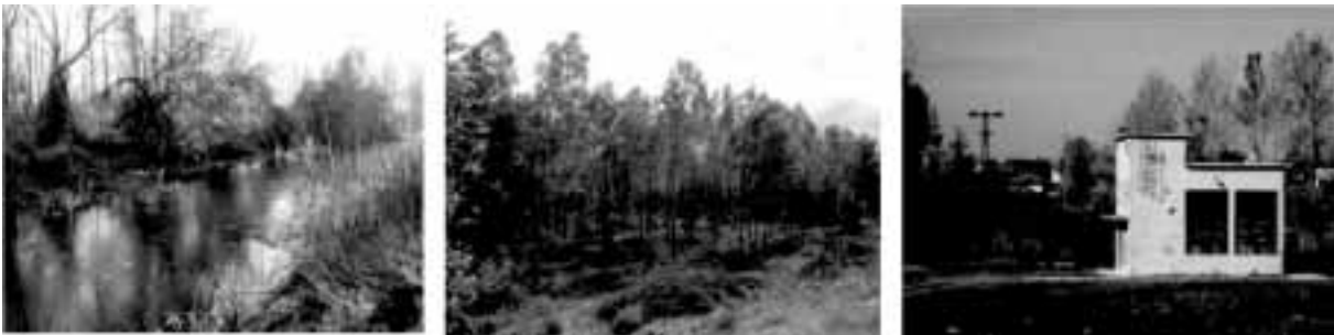
Слика 2 – Отворени канали, ретензије и црпна станица
